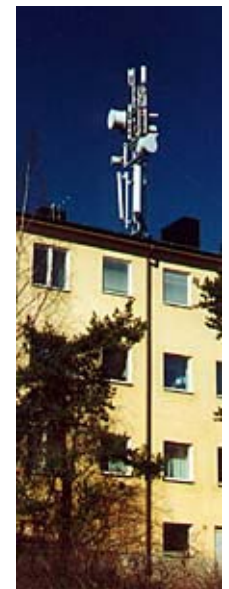
Fyra antenner och fyra mikrovågslänkar
