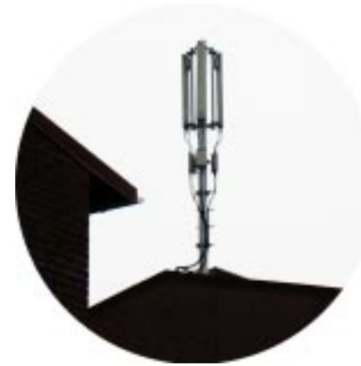
Tre antenner på en låg mast på ett hustak.
